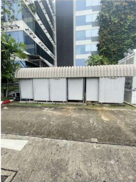
ภายนอกโรงที่ตั้งปั้มน้ำดับเพลิง
